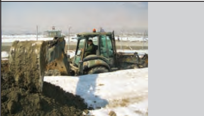
Απομάκρυνση ποσοτήτων αδρανών υλικών σε υπό διάνοιξη αντιστοίχων τάφρου στην περίμετρο του ΚΑΙΑ.
