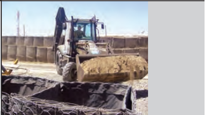
Κατασκευή αναχώματος στο ΚΑΙΑ
