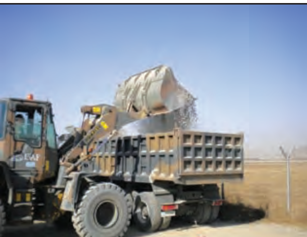
Απομάκρυνση ποσοτήτων αδρανών υλικών σε υπό διάνοιξη αντιστοίχων τάφρου στην περίμετρο του ΚΑΙΑ.
